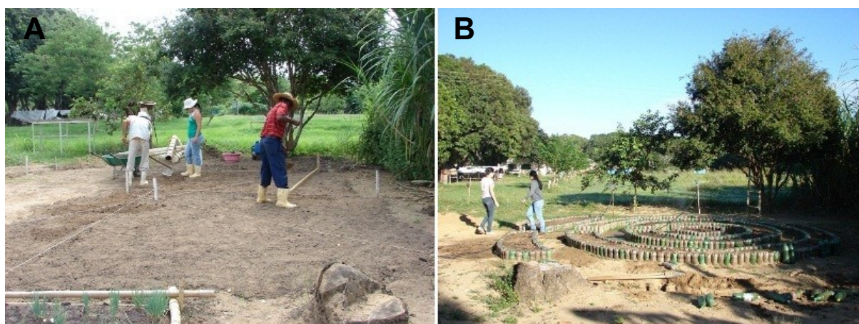
Figura 1. Nivelamento e delimitação dos canteiros e caminhos (A), construção dos canteiros (B).
