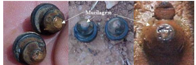
Figura 1. Detalhe mostrando a formação de mucilagem na entrada dos gotejadores e nas paredes internas das tubulações
