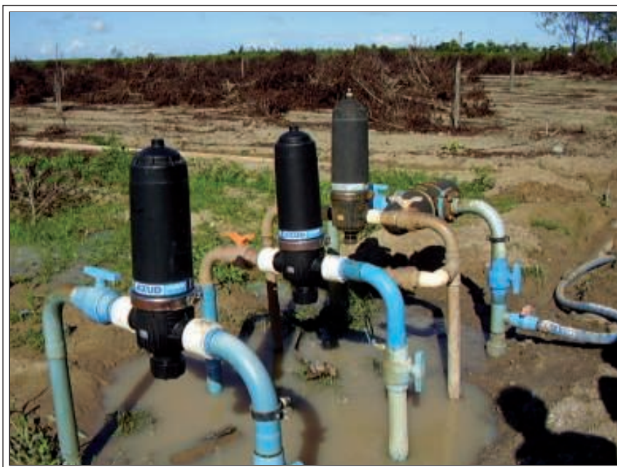
Figura 10. Estação de controle de sistema de irrigação localizada.
