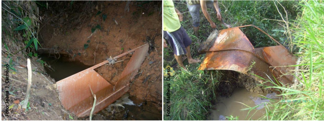
Figura 13 – Fotos tiradas após os rompimentos do vertedores instalados na área PSC
