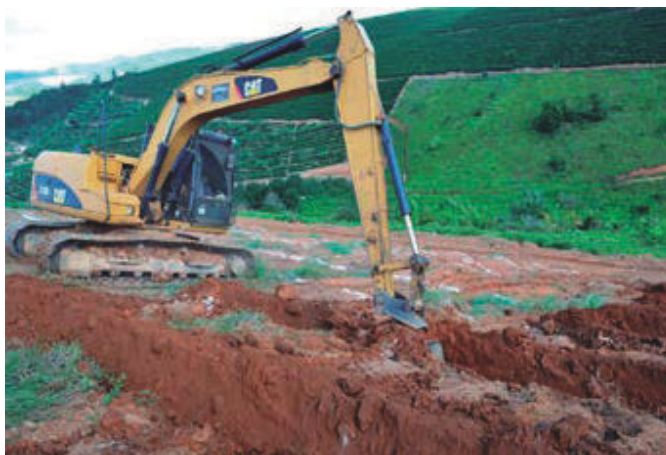
Figura 1. Escavadora hidráulica com rodado de esteira e subsolador adaptado no braço hidráulico-mecânico abrindo os sulcos para o plantio de café conilon em terreno declivoso no noroeste do Espírito Santo.
