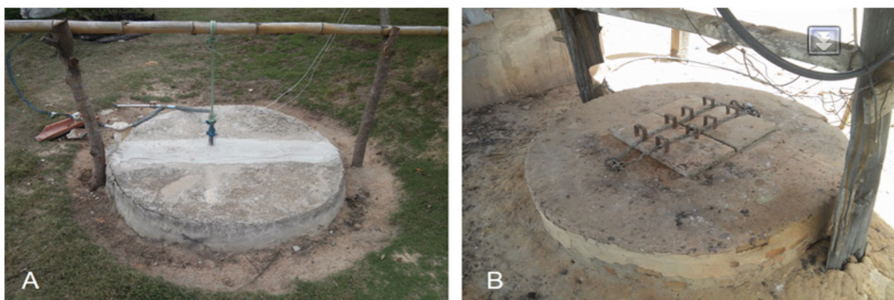
Figura 2. Cacimbas em uso, sem as devidas proteções sanitárias (A;B). Fonte: Autor, 2016.
