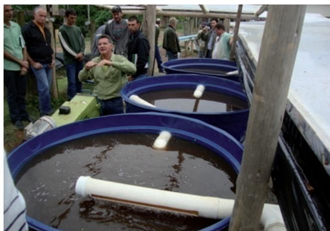
Figura 2A. Sistema de limpeza de águas residuárias: caixas de decantação.
