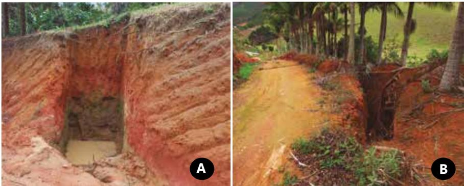
**Figura 20.** Caixas-secas no interior das lavouras de café (A) e nas estradas (B).
