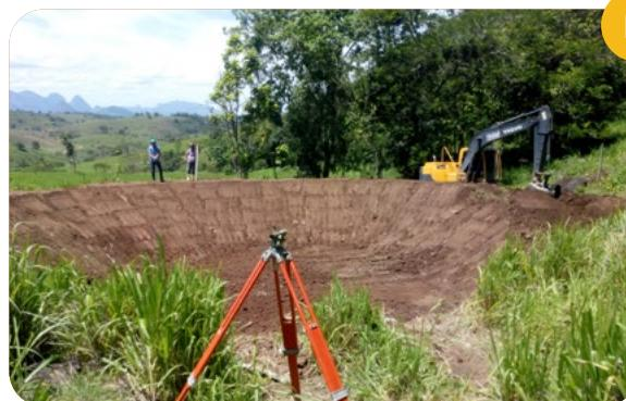
**Figura 6** – Execução e acompanhamento de obra das barraginhas construídas nas UR de Água Doce do Norte (A, C), Marilândia (B) e Cachoeiro de Itapemirim (D).
