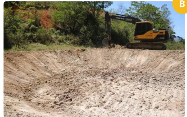
**Figura 1** – Implantação das barraginhas nas Fazendas Experimentais de Marilândia (A) e Bananal do Norte Pacotuba - Cachoeiro de Itapemirim (B).
