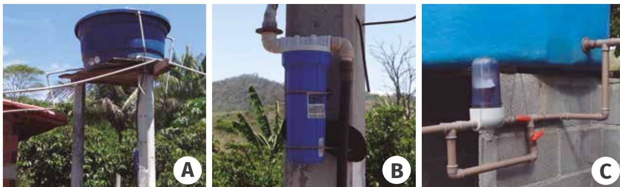
**Figura 6** – Instalações e tratamento da água em agroindústria: reservatório (A); filtro (B); e dosador de cloro (C).
