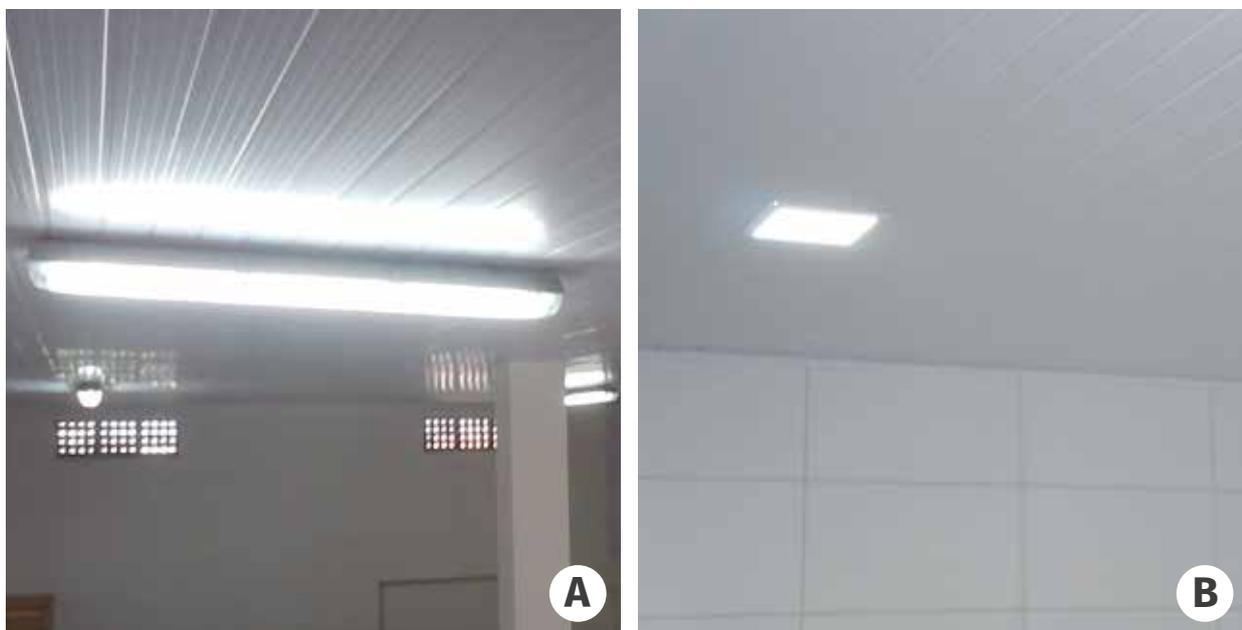
**Figura 8** – Exemplos de iluminação artificial: luminária com proteção (A), placa de LED que dispensa proteção adicional (B).
