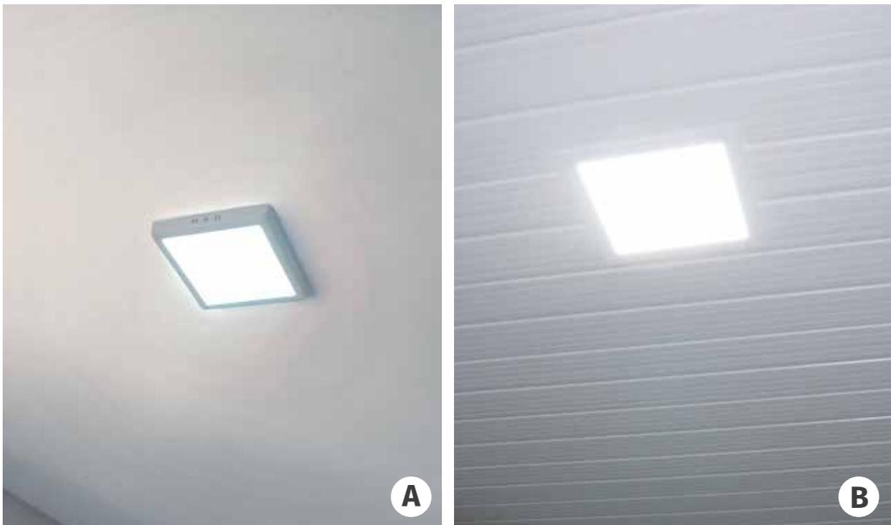
**Figura 3** – Tipos de teto e forro utilizados nas agroindústrias: laje de alvenaria revestida por tinta (A); forro em PVC branco (B).
