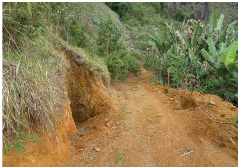
**Figura 2** - Caixas secas construídas na estrada interna da propriedade.
