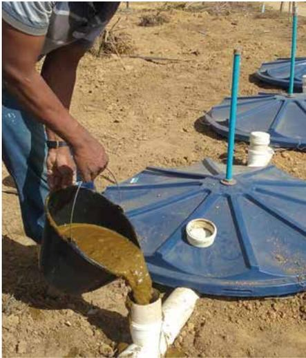
**Figura 3** - Fossa séptica biodigestor para tratamento de esgoto doméstico.
