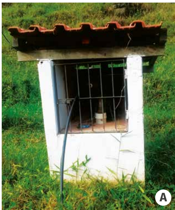
Figura 1 – Captação de água em poço escavado (A) e detalhe da figura 1A (B).
