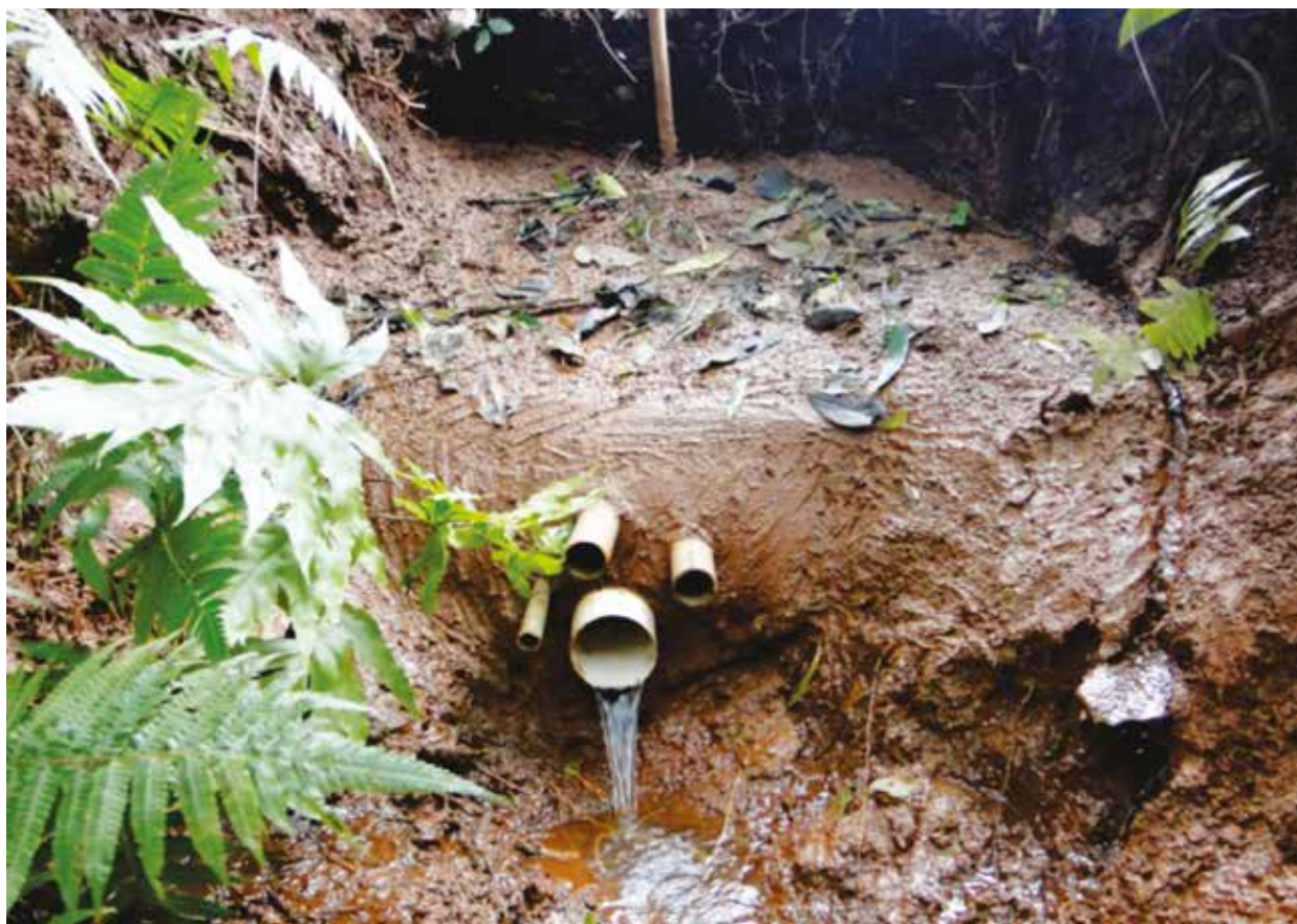
Figura 2 – Captação de água em nascente.
