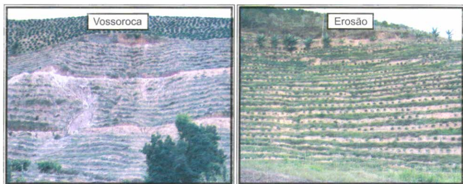
Figura 11 - Algumas consequências da inadequada utilização de práticas de conservação de solo.
