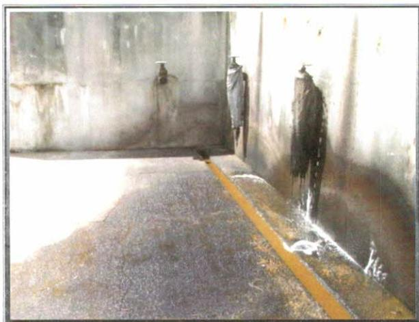
**Figura 17.** Canaleta para escoamento de água residuária.
