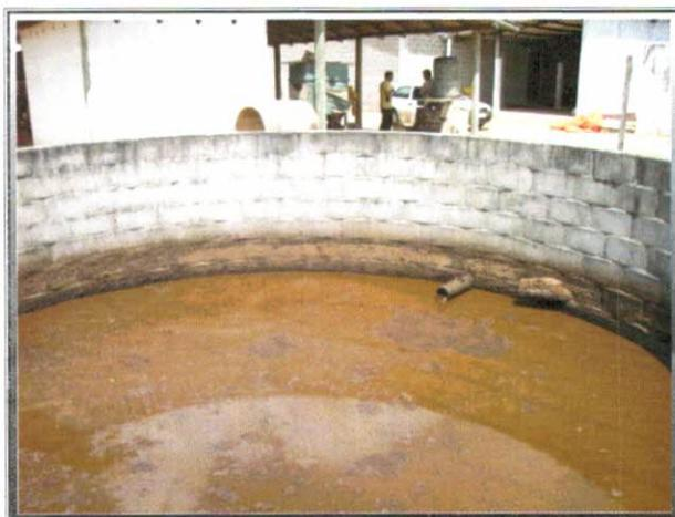
**Figura 18.** Tanque de decantação da água residuária.
