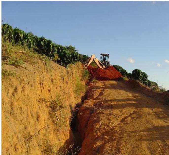
Construção das caixas secas
