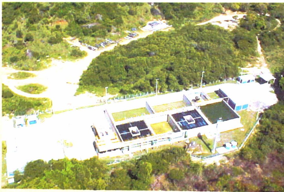
Estação de Tratamento de Esgoto de Mulembá - Cesan - Vitória.
