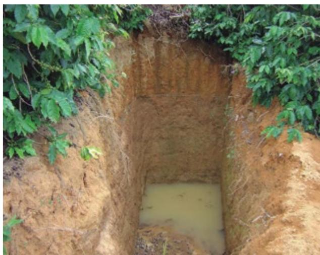
**Figura 4.** Caixa trapezoidal de captação de água ao longo de estrada de terra.
