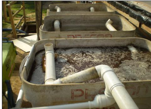
FIGURA 4. Vista parcial do sistema de remoção de sólidos suspensos da Fazenda Experimental de Venda Nova em funcionamento (Caixas removedoras de impurezas), Venda Nova do Imigrante-ES.
