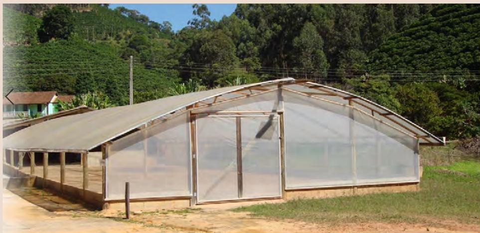
**Figura 6** – Terreiro de concreto, com cobertura de PVC para secagem de café.
