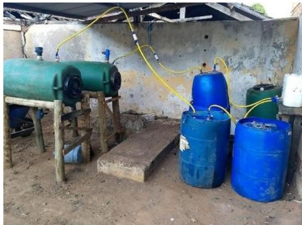
FIGURA 1: Biodigestor Portátil construído em uso na fazenda.
