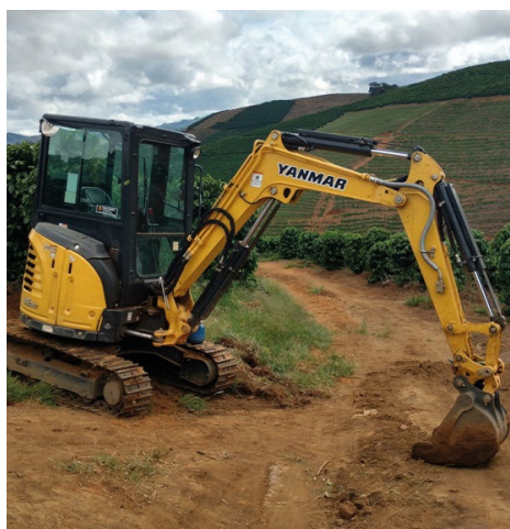
Figura 5 – Microterraceamento com miniescavadeira de esteira com concha escavadeira e lâmina dianteira para acerto do terraço.
