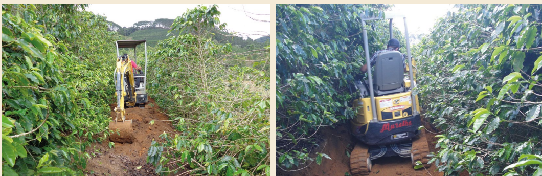
Figura 9 – Construção de microterraços em lavouras implantadas.
