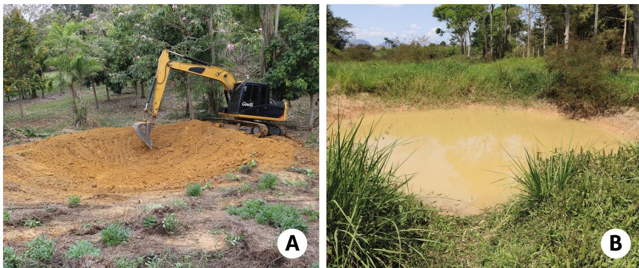
Figura 34 – Implantação das barraginhas na Fazenda Experimental de Marilândia do Incaper (A) e o acúmulo de água de chuvas nas barraginhas (B).
