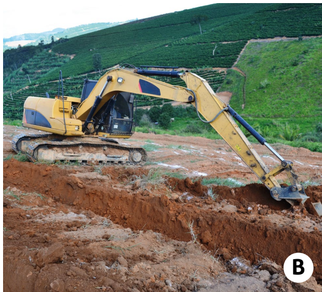
Figura 2 – Escavadeira hidráulica utilizada para preparo de sulcos em áreas declivosas (A, B).
