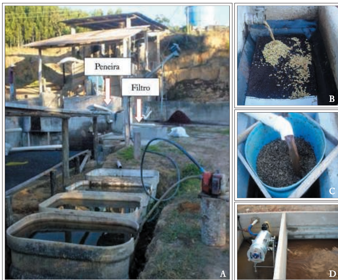
Figura 2. Estruturas para recirculação de água na unidade processadora: caixas de decantação (A); peneira (B); filtro orgânico (C); filtro mecânico (D).
