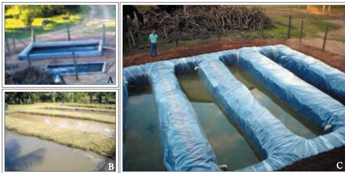
Figura 3. Tratamento da água residuária dos frutos do cafeeiro: tanque de sedimentação e lagoa anaeróbica (A); lagoas facultativas (B); lagoas de fitorremediação (C).
