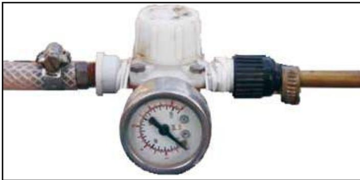
**Figura 4** - Reguladores de pressão do tipo registro, com manômetro.
